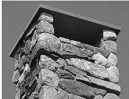
Stone Cap Chimney Top
